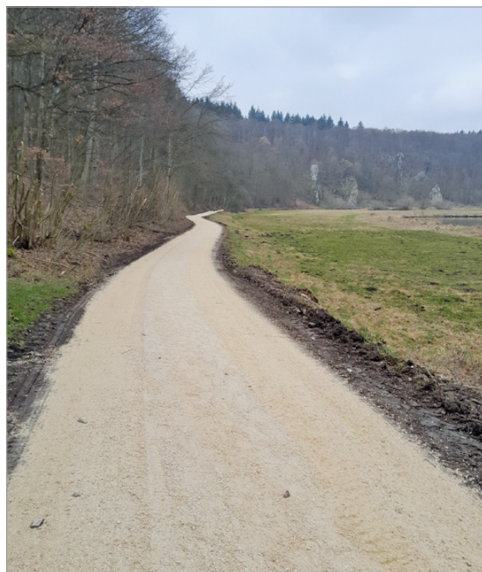
(Instandgesetzter innerer Talweg im Eselsburger Tal, im Hintergrund die nun gut sichtbaren, frisch gepflegten Felsen.)
