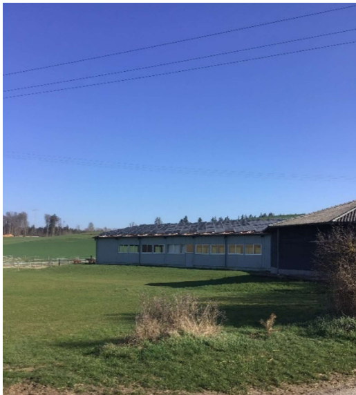
Abbildung 9: Blick von Osten auf die bestehende Bebauung nördlich des Plangebietes (Quelle: Eigene Aufnahme)
