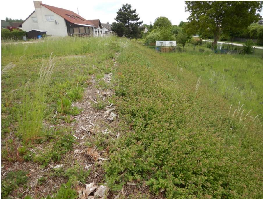
Foto 1: süd-exponierte Böschung, die bereits wieder zuwächst
