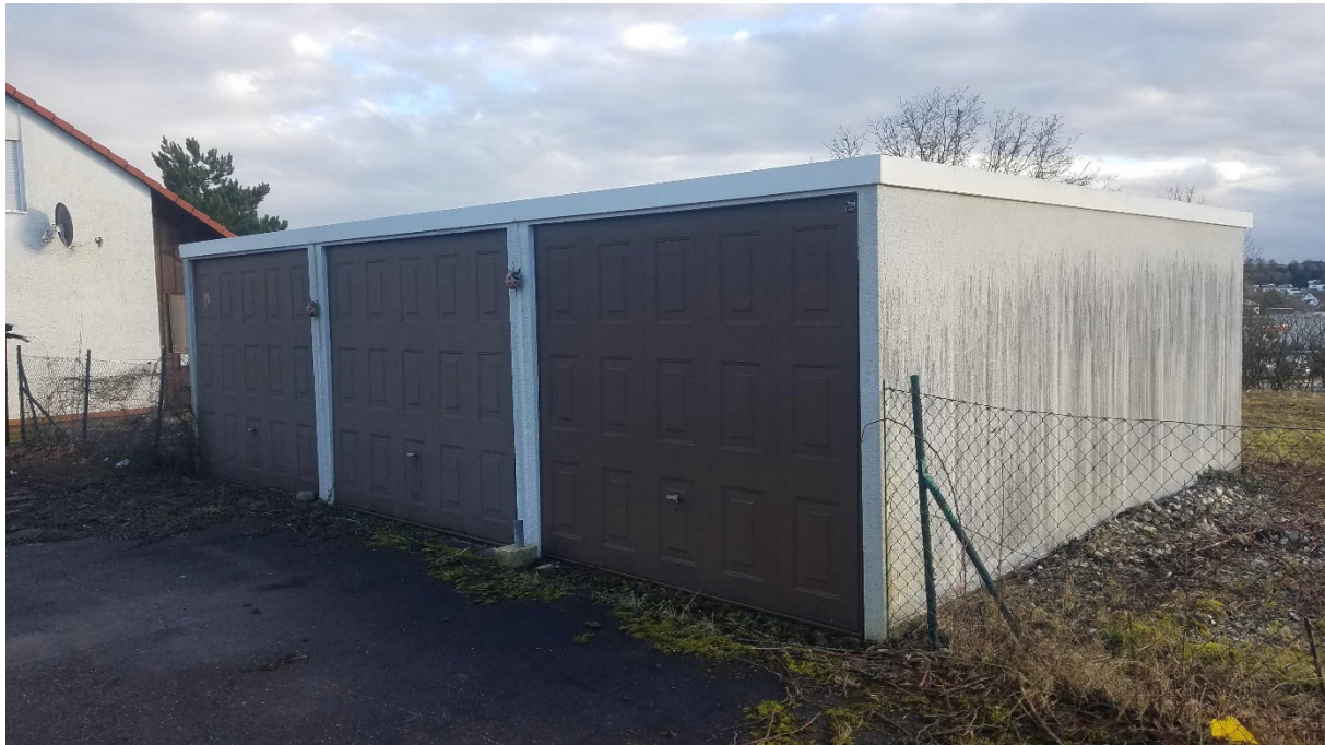
Abbildung 2: Die Fertigteil-Dreifachgarage mit Blickrichtung Süd.
