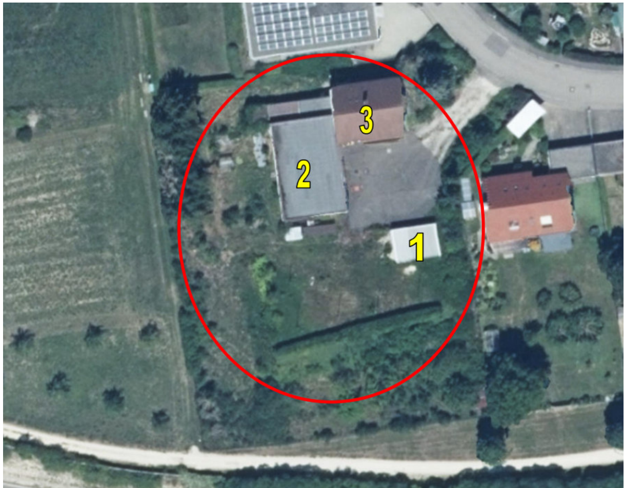
Abbildung 1: Roter Kreis = Abrissgebäude, Südlich (Ziffer 1): Dreifachgarage, Westlich (Ziffer 2): Werkstatt mit nördl. Anbau, Nördlich (Ziffer 3): Wohngebäude
