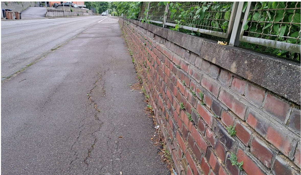
Abbildung 17: Ziegelwand im Bereich des Geländeabfangs zwischen Heidenheimer Straße und Lagergebäude. (Quelle: Eigene Aufnahme vom 22.05.2025).
