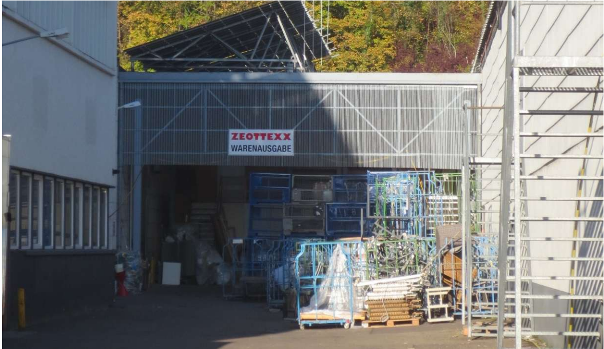
Abbildung 8: Blick von Osten auf die Westliche Lagerhalle.
