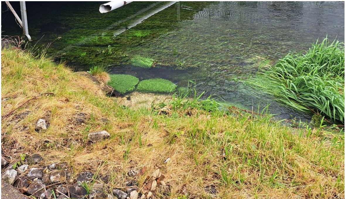
Abbildung 12: Triebwerkskanal Zöbritz Gewässer 2. Ordnung mit kiesiger Sohle und üppigem Sohlebewuchs.
