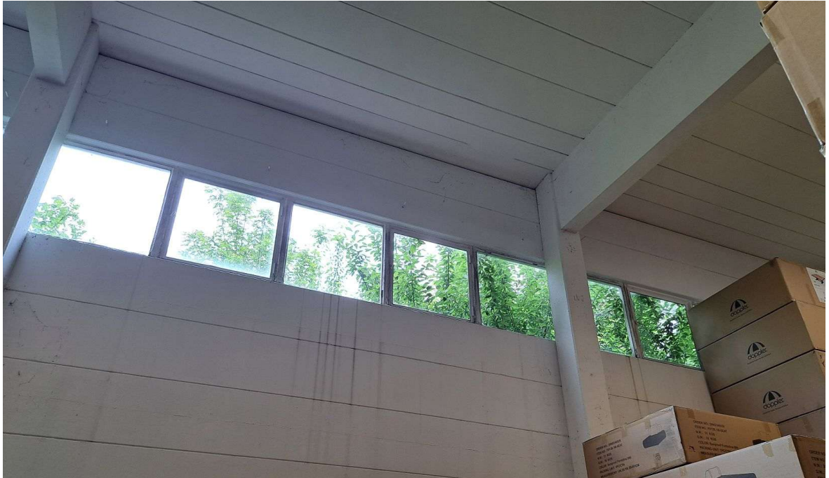
Abbildung 26: Innenansicht westliches Lagergebäude mit Blick auf die straßenbegleitende Hecke.
