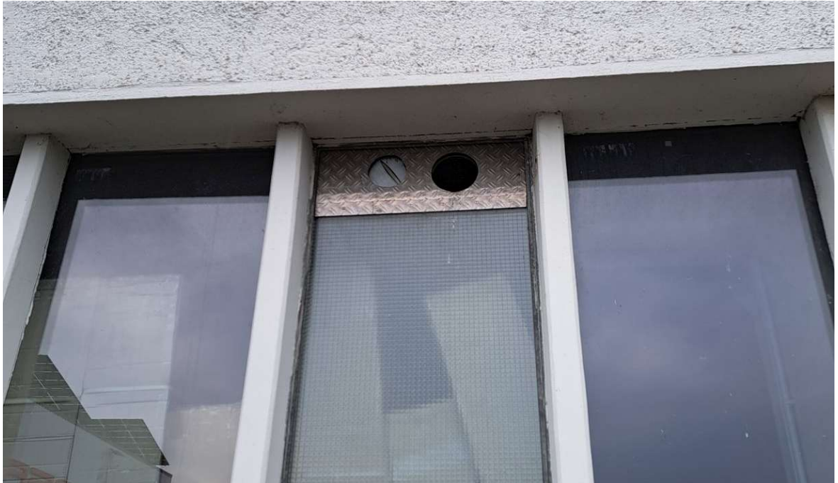
Abbildung 28: Lüftungsöffnungen in der Westfassade des östlichen Lagergebäudes. (Quelle: Eigene Aufnahme vom 22.05.2025).
