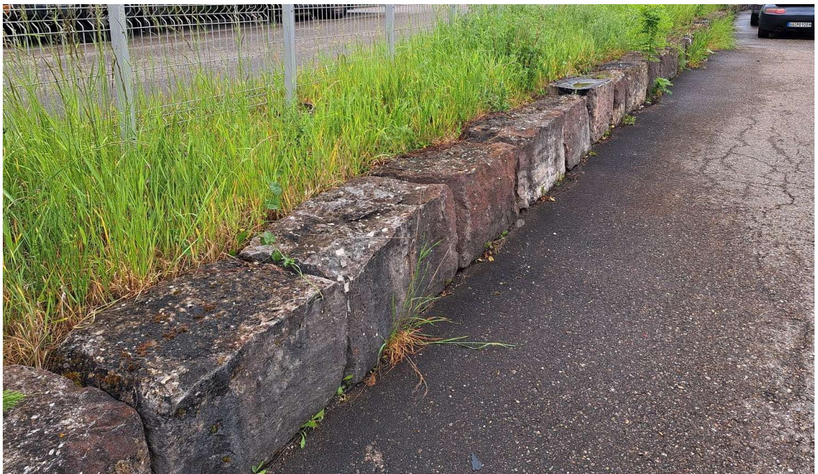
Abbildung 14: Natursteinmauer gegenüber der Ruderalfläche auf dem Nachbargrundstück.
