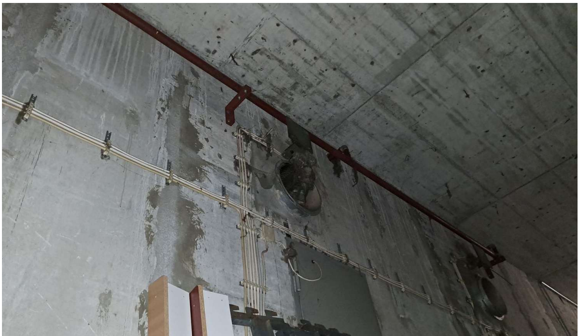
Abbildung 22: Staffelgeschoss im Norden: Betonwände unverputzt mit Lüftungsöffnungen.
