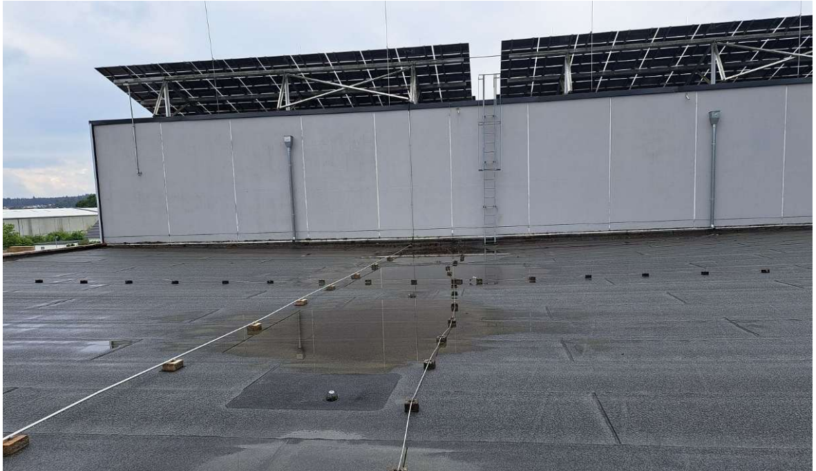
Abbildung 21: Dachdeckung im Bereich des geplanten Abrisses mit anschließendem Nachbargebäude.
