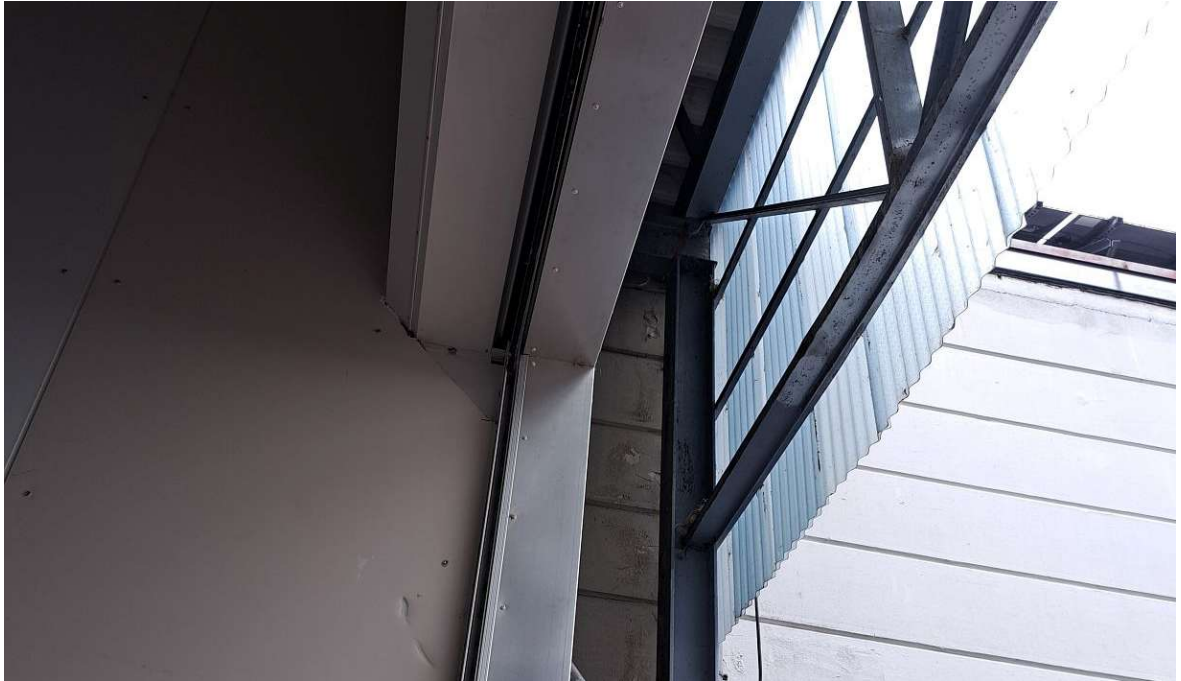
Abbildung 24: Rolltor an der Ostfassade des nordwestlichen Gebäudes. (Quelle: Eigene Aufnahme vom 22.05.2025).
