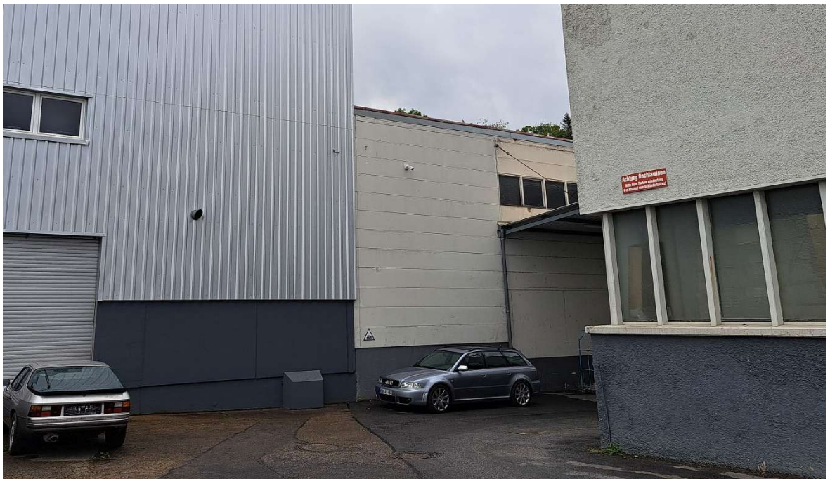
Abbildung 11: Blick von Westen auf den Abrissbereich des Gebäudes mit angrenzendem Nachbargebäude (silberne Blechverkleidung). (Quelle: Eigene Aufnahme vom 22.05.2025).
