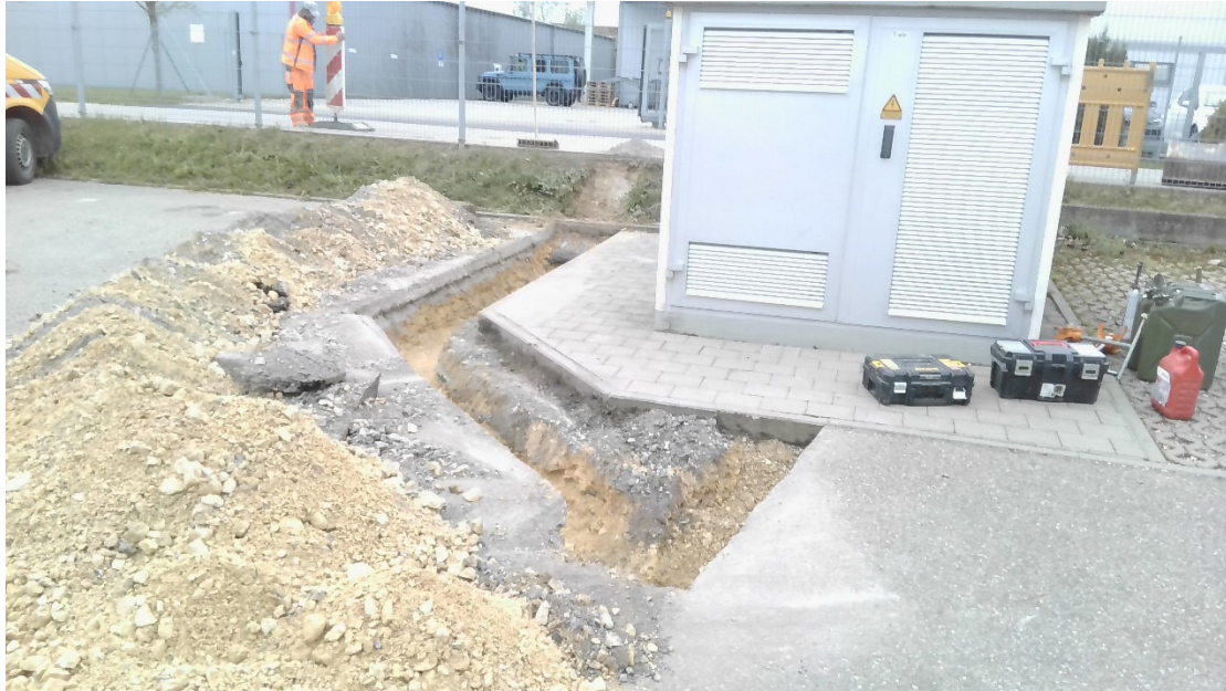
Abbildung 1: Hausanschlussherstellung Ziegelei
