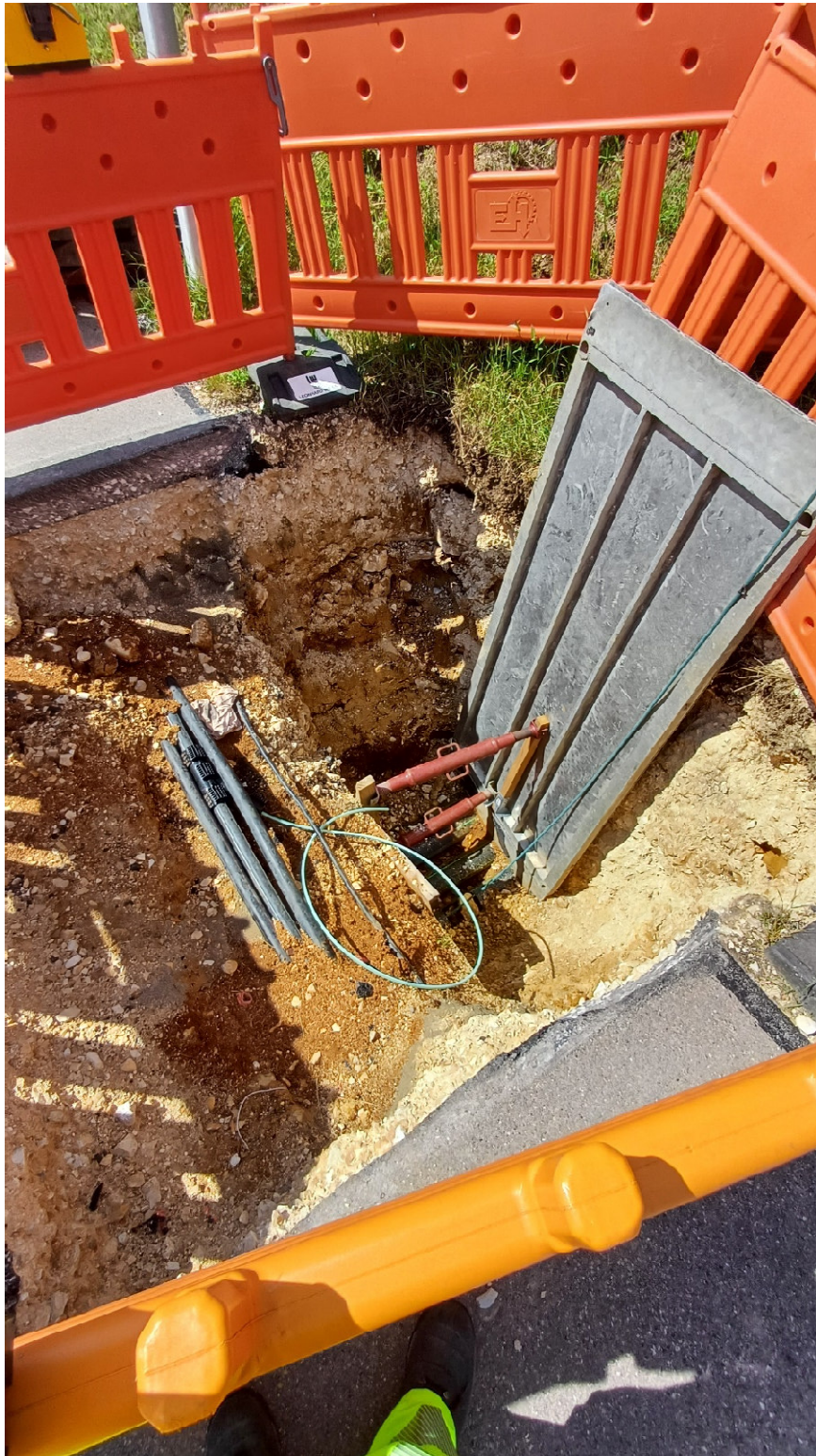
Abbildung 3: Hausanschlussherstellung Beim Brünnele
