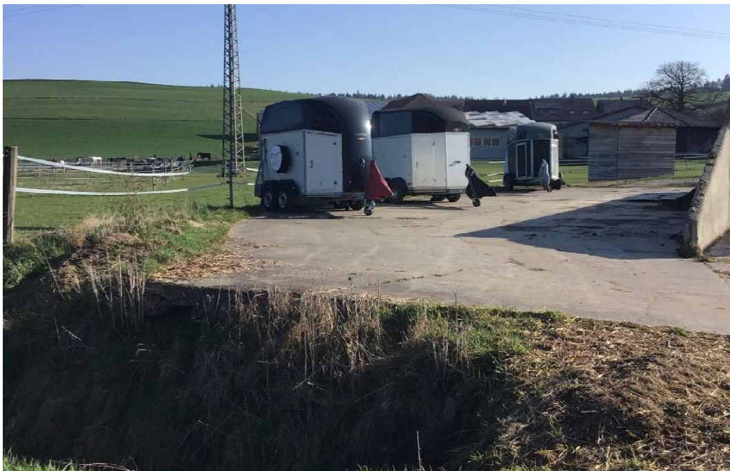
Abbildung 10: Betonierter Fahrfläche des Fahrsilos mit Abstellfläche für PKW und (Pferde-) Anhänger; im Vordergrund der Graben. (Quelle: Eigene Aufnahme vom 03.04.2025).
