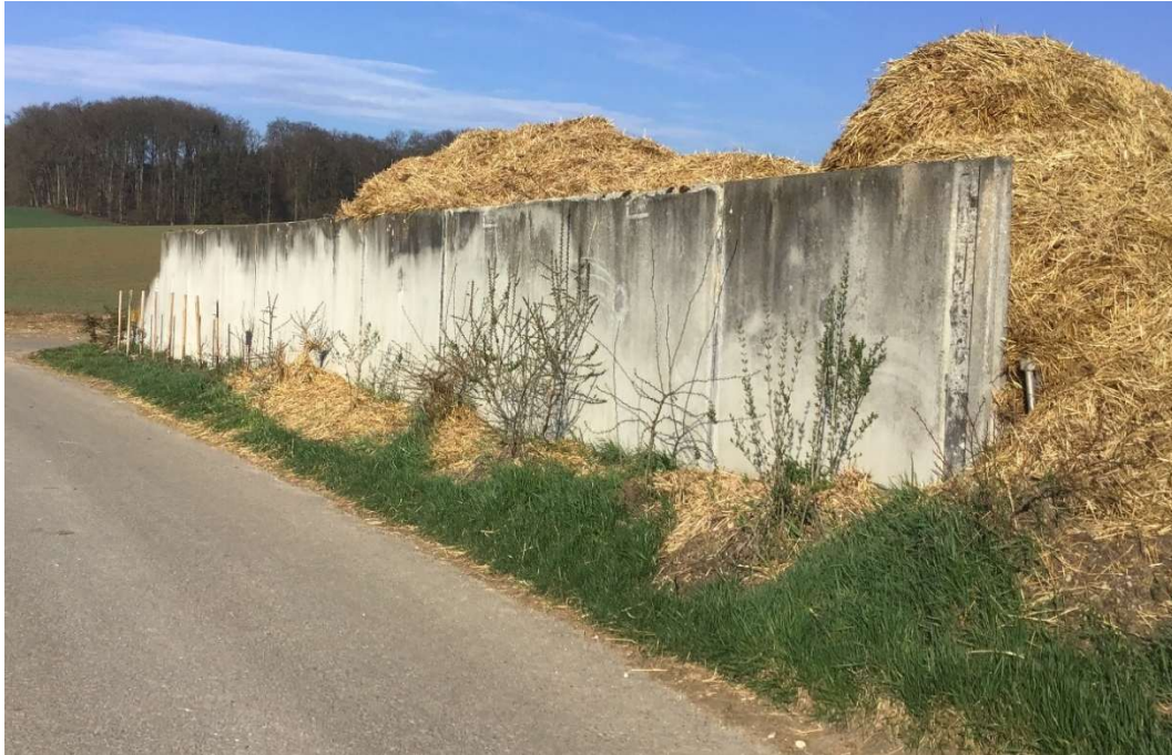
Abbildung 9: Fahrsilo mit betonierter Fahrfläche und den frisch gepflanzten Gehölzen. (Quelle: Eigene Aufnahme vom 03.04.2025).
