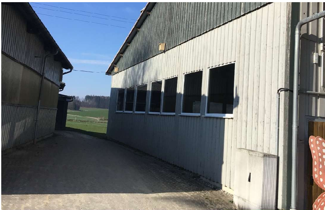
Abbildung 18: Blick nach Süden auf die Vorhabenfläche; Links das Strohlager, dahinter die Longierhalle, Rechts eine Reithalle mit 20x40 m mit weiteren Nistkästen.
