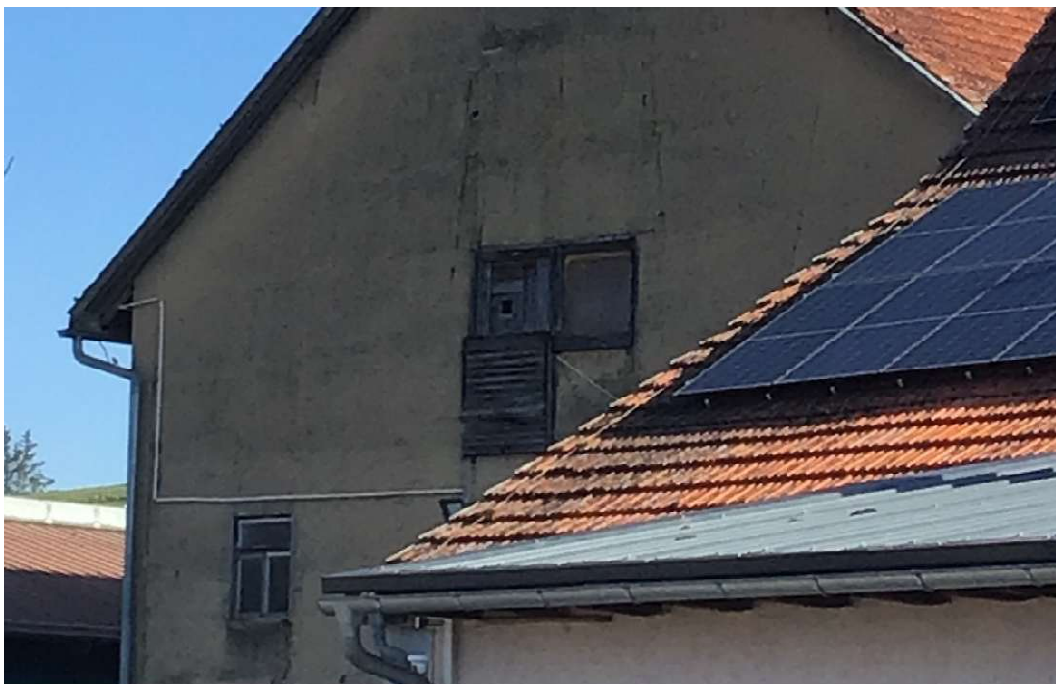
Abbildung 20: Blick auf die südliche Fassade eines der Stallgebäude; Nistplatz des ansässigen Turmfalkenpärchens im Dachfirst (Zugangsloch).
