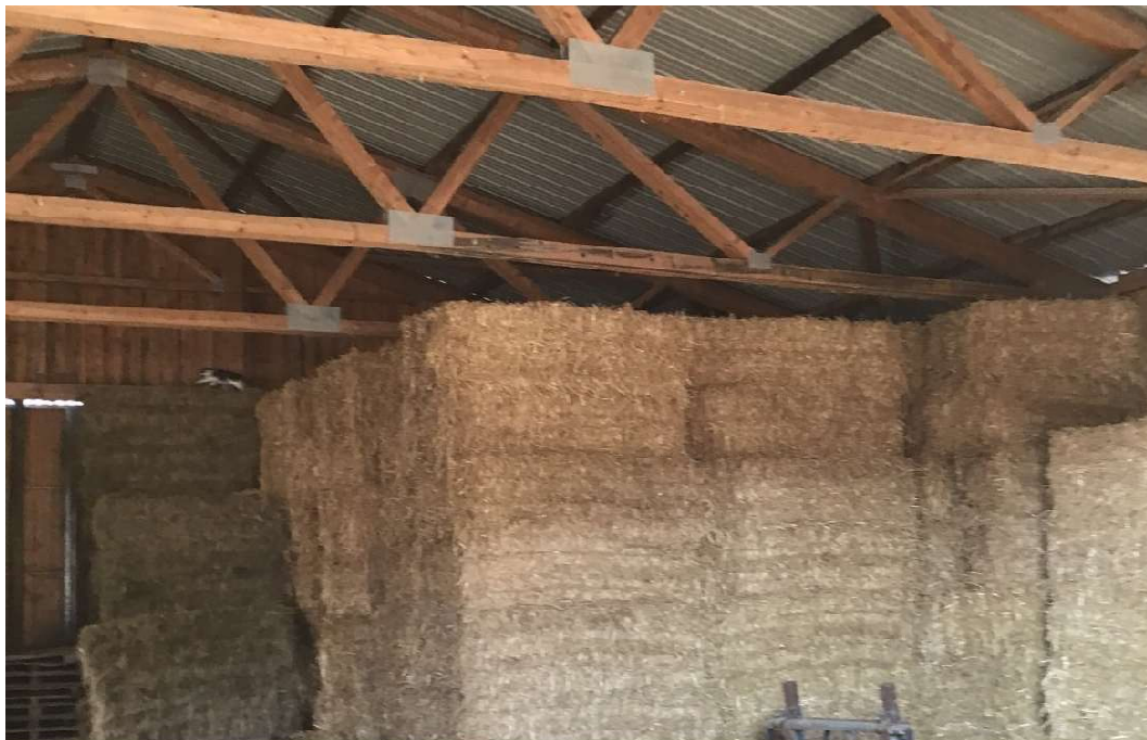
Abbildung 16: Strohlager ohne spezifische Nistplatznachweise. (Quelle: Eigene Aufnahme vom 03.04.2025).
