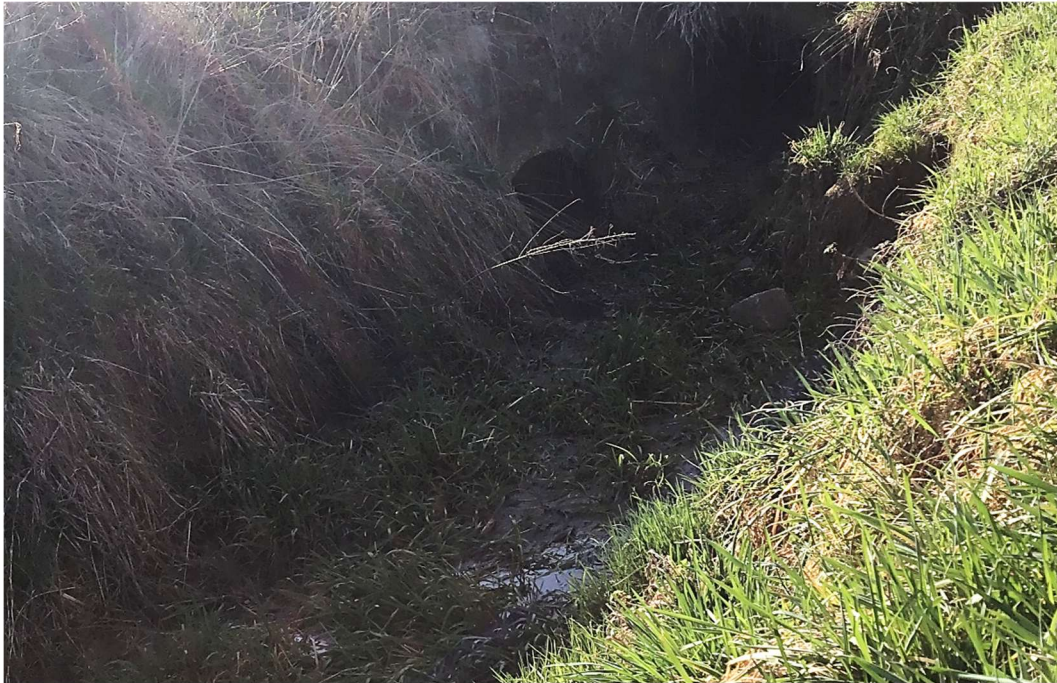
Abbildung 11: Graben (Ugentalgraben) mit Verrohrung im Querungsbereich der Straße und trockenen, steilen Uferböschungen, gering wasserführend im Sohlebereich.
