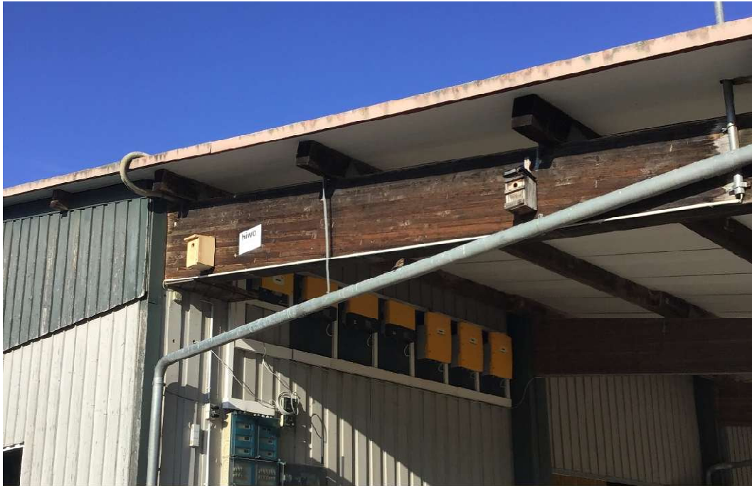
Abbildung 18: Zahlreiche Meisennistkästen an allen Gebäuden, teilweise besiedelt. (Quelle: Eigene Aufnahme vom 03.04.2025).
