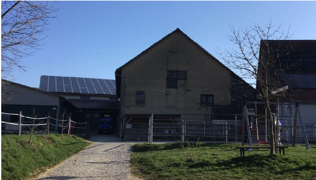
Abbildung 20: Blick auf die südlichen Fassaden der Stallgebäude; Freigelände mit unterschiedlicher Geländebefestigung, teilweise ungebunden, teilweise befestigt, Grünflächen als Nutzrasen. (Quelle: Eigene Aufnahme vom 03.04.2025).
