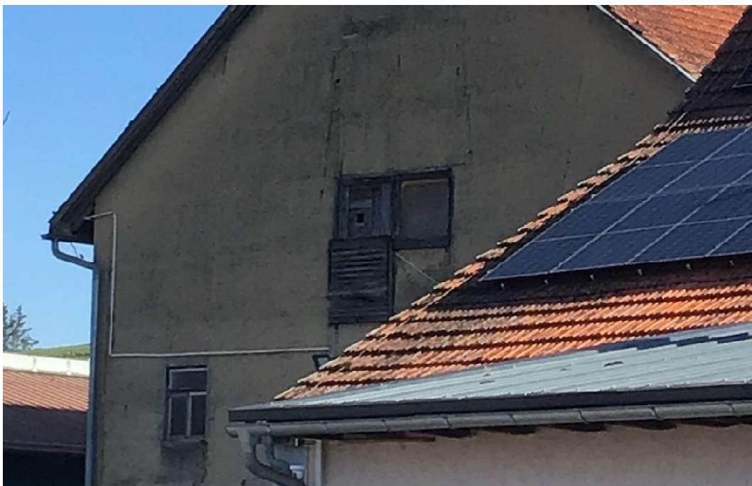
Abbildung 21: Blick auf die südliche Fassade eines der Stallgebäude; Nistplatz des ansässigen Turmfalkenpärchens im Dachfirst (Zugangsloch). (Quelle: Eigene Aufnahme vom 03.04.2025).
