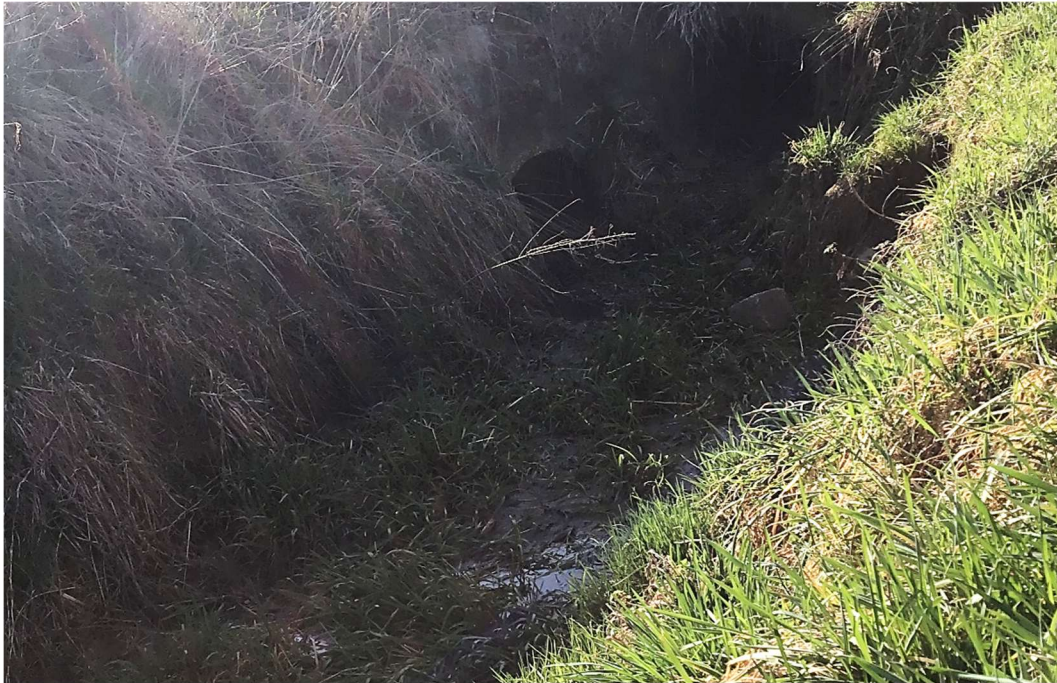
Abbildung 12: Graben (Ugentalgraben) mit Verrohrung im Querungsbereich der Straße und trockenen, steilen Uferböschungen, gering wasserführend im Sohlebereich.
